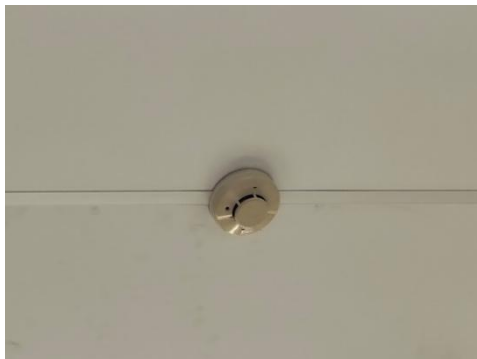
อุปกรณ์ตรวจสอบความร้อน (Heat Detector)
