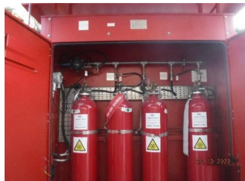
ระบบดับเพลิงแบบก๊าซคาร์บอนไดออกไซด์
