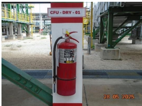
ถังดับเพลิงแบบมือถือ (Portable Cry Chemical Fire Extinguisher)
