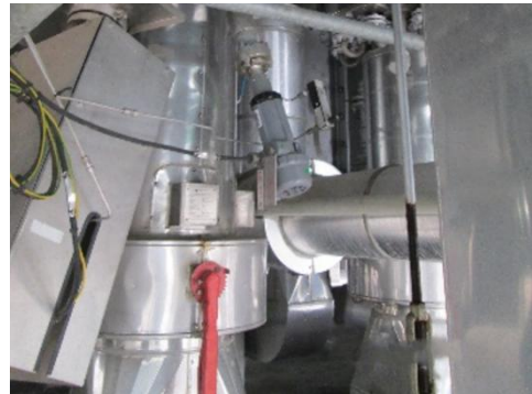
ระบบตรวจสอบไฟ (Flame Detection)
